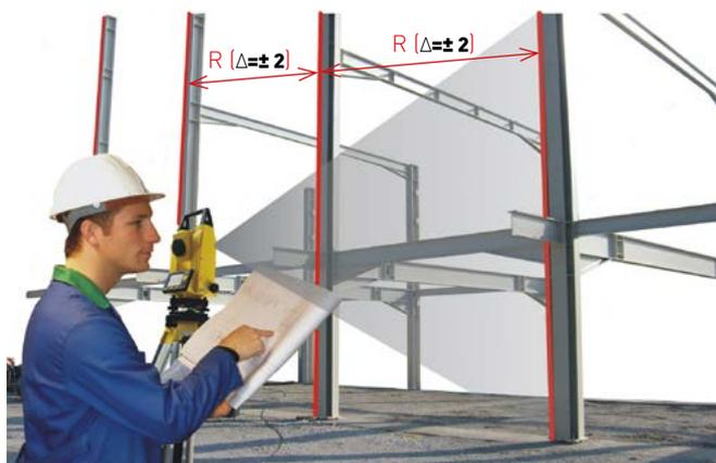
4. Допустимое отклонение - вертикального выравнивания конструкции в углах не должно превышать 1 мм/1м высоты.
