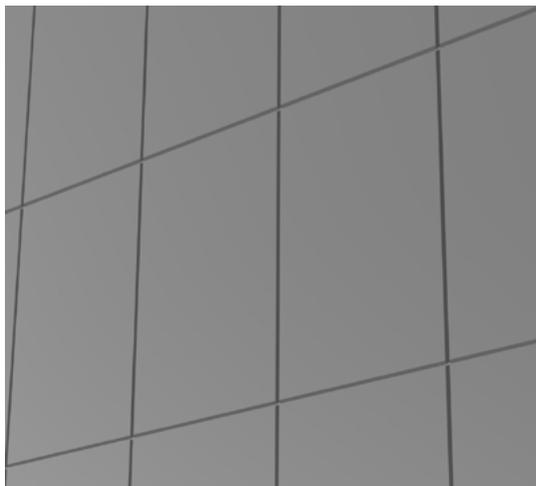
Вертикальная модульная фасадная система составлена из отдельных фасадных элементов, соединенных между собой в вертикальном направлении (продольно) по принципу паз и гребень и прикрепленных горизонтально (поперечно) к несущей конструкции. Для герметизации обоих вертикальных стыков используются интегрированные уплотнители и дополнительно герметизирующая замазка в угловом элементе EPDM а для горизонтальной герметизации (горизонтальный шов) используются уплотнительные профили.
